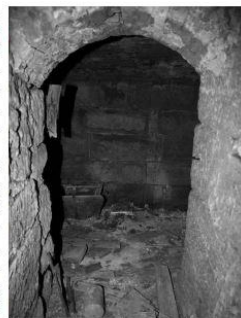
Zugang zum Keller unter dem Stadel
